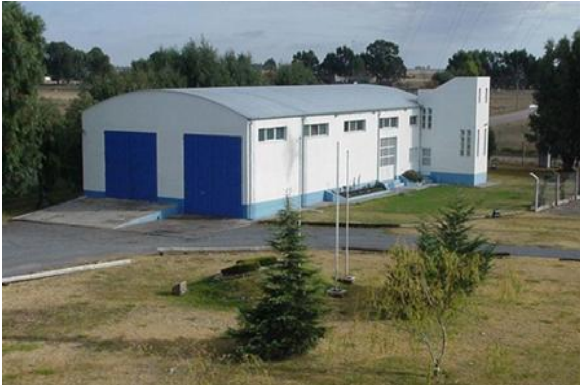
Figura N° 4. Sala Extracción Cooperativa (Fuente: Julio Lemos).
